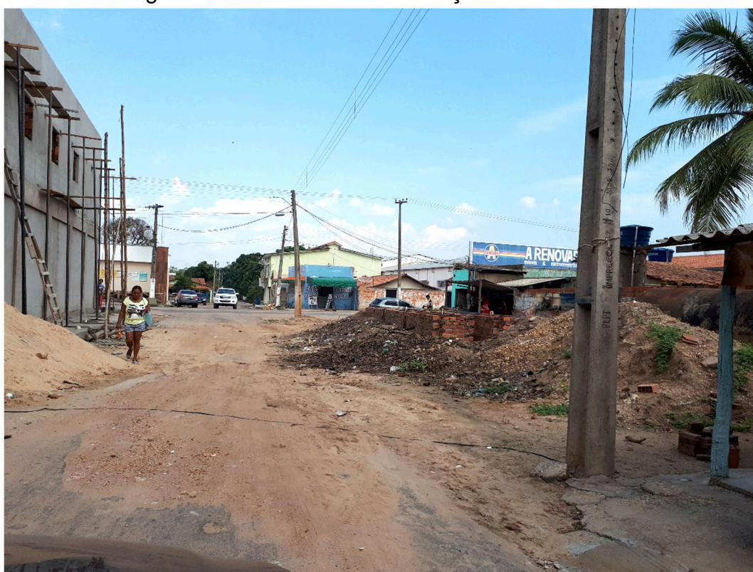
Figura 47: Resíduos de construção civil na cidade.
