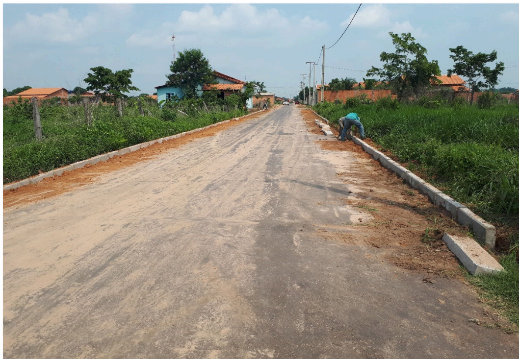
Figura 40: Via pavimentada dotada de meio-fio e sarjeta.
